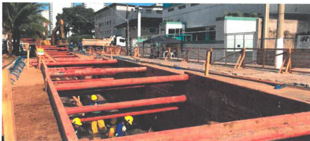
Blindagem de Valas Utilizada pela VPA Equipamentos - www.vpaequipamentos.com.br
