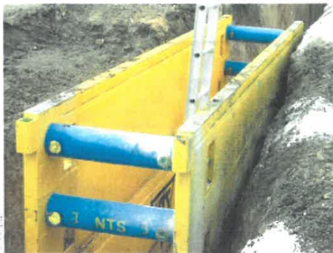
As paredes (das módulos são fornecidas em tamanhos padronizados para obras diversas, como em instalação de coletor tronco, poço de visita e estação elevatória
