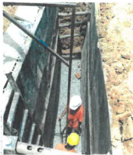
A blindagem pode ser usada tanto como reforço da vala em situações de reparo quanto em escavações novas
